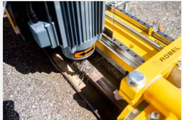
Rainure de drainage avec fraiseuse de rail ROFACE
