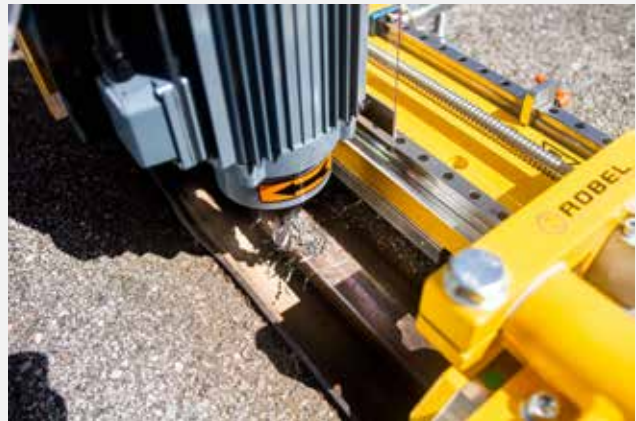
Ranura de drenaje con fresadora de carril ROFACE
