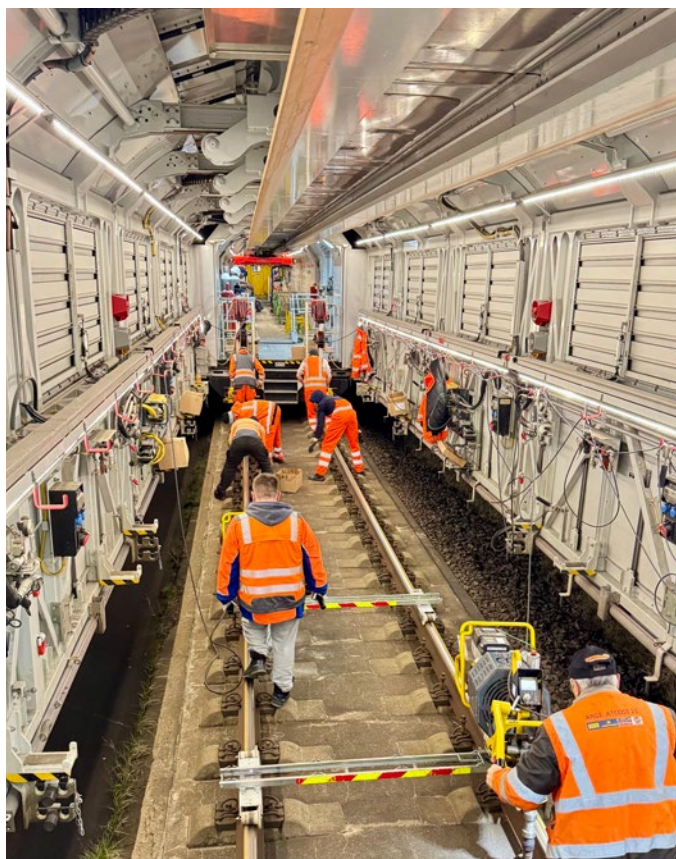
Abb. 3: Romis Work: kontinuierliche Kleineisensanierung im Fließbandverfahren
