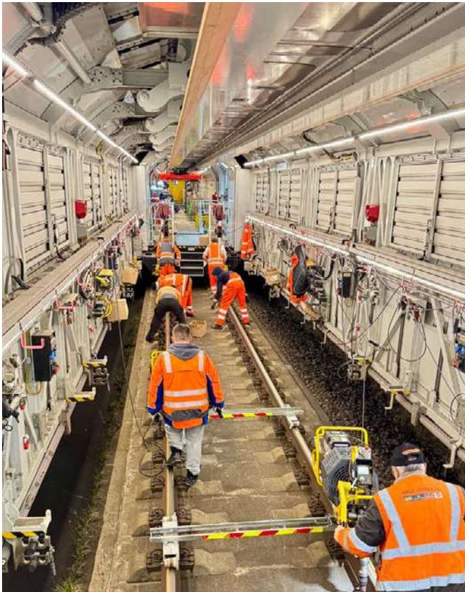
Abb. 3: Romis Work: kontinuierliche Kleineisensanierung im Fließbandverfahren
