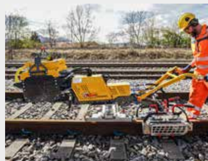
ROCLIP 34.02 Modulare Clipmaschine
