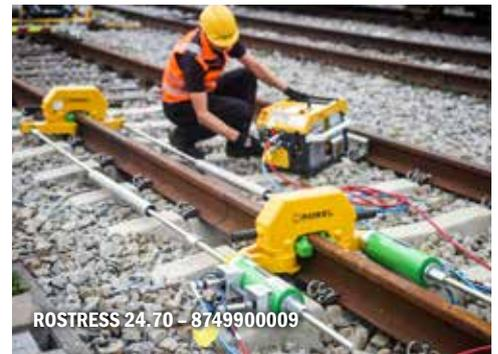
**Das Modulkonzept zum Herstellen einer neutralen Schienenspannung bei Schweiß- und Verspannarbeiten.**
