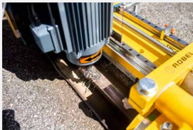
Ranhura de drenagem de água com fresadora de trilhos ROFACE
