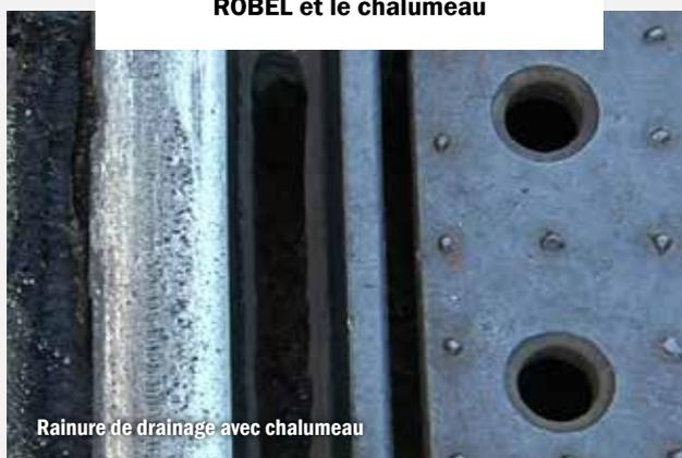
Rainure de drainage avec chalumeau
