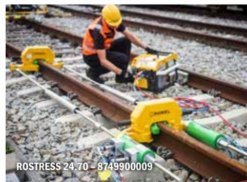
**Le concept modulaire pour établir une tension de rails neutre lors des travaux de soudures et de serrage.**
