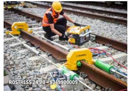
**Concepto modular para generar una tensión de carril neutra en trabajos de soldadura y refuerzo.**
