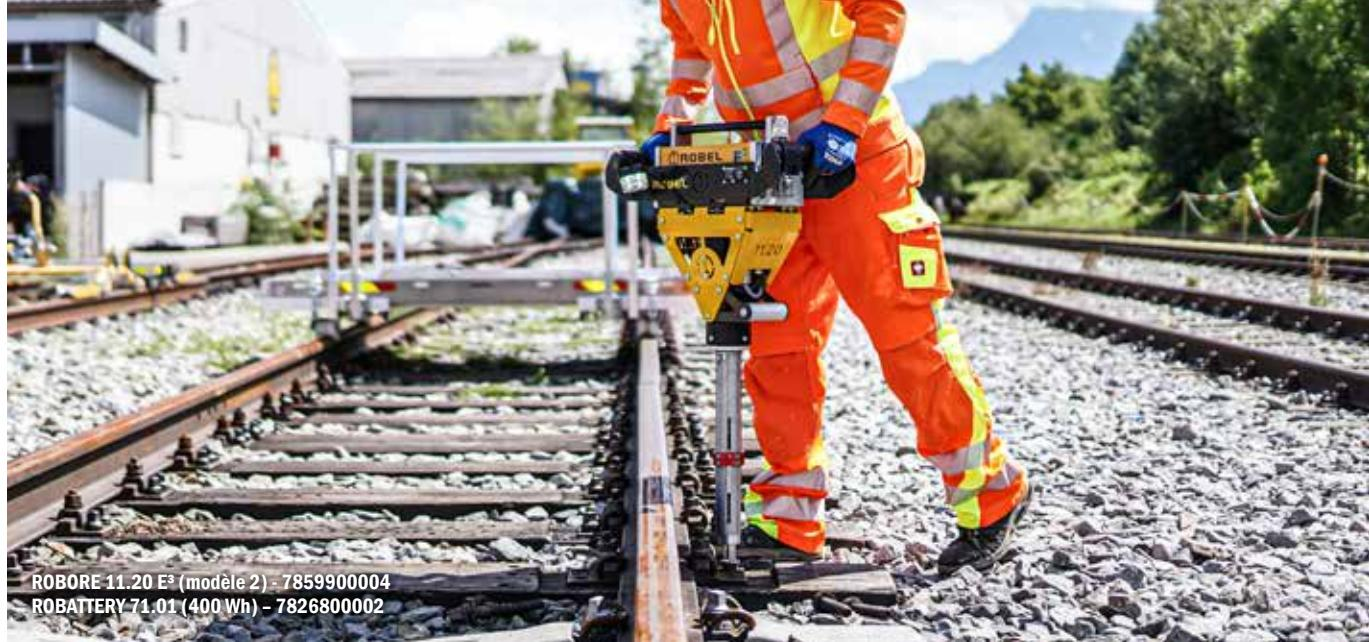
Perceuse de traverses portable pour percer les traverses en bois et en matériaux synthétiques
