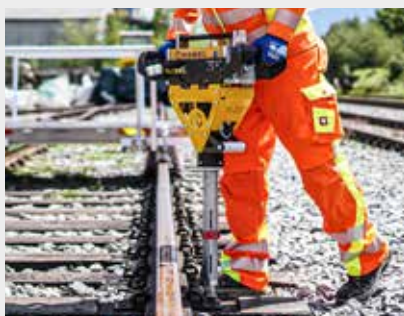
ROBORE 11.20 E 3 Perceuse de traverses sur batterie
