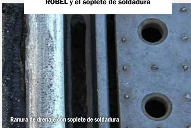
Ranura de drenaje con soplete de soldadura
