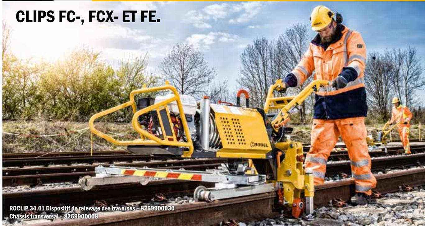
ROCLIP 34.01 Dispositif de relevage des traverses – 8259900030
