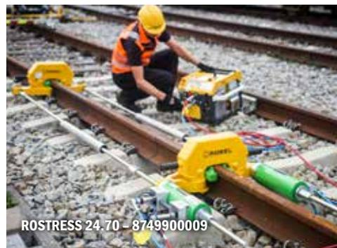
**Das Modulkonzept zum Herstellen einer neutralen Schienenspannung bei Schweiß- und Verspannarbeiten.**
