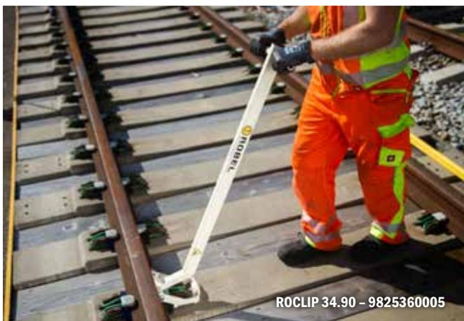
Ferramenta de inserção para inserir manualmente grampos-trilho FC, FCx e FE
