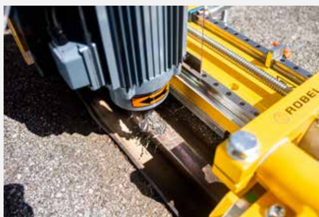
Rowek drenażowy do odprowadzania wody z frezarką do szyn ROFACE
