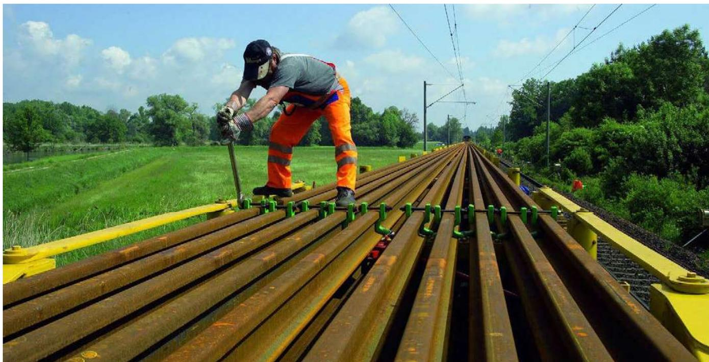
**Abb. 6:** Ein Bild, das bald der Vergangenheit angehört: Das riskante manuelle Verschrauben des Ladegutes entfällt, zu keiner Zeit befinden sich Personen auf der Einheit.
