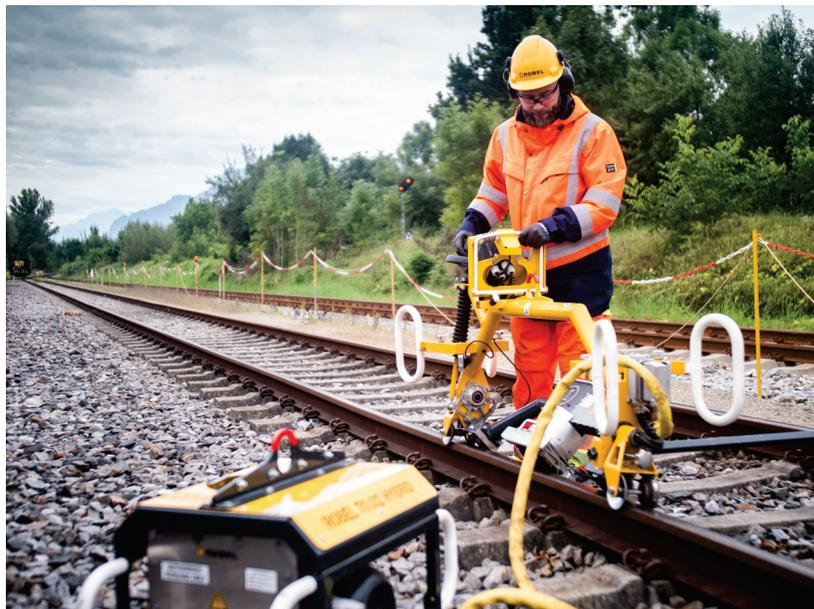
*Durch das Konzept des Hybridantriebs ist die Schienenkopf-Schleifmaschine 13.49 nur halb so schwer wie herkömmliche Schleifmaschinen und liefert genaue Profilierung in kürzerer Zeit.*
