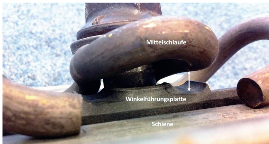
**Abb. 1:** Die geometrische Sollverspannung beim W-Oberbau liegt laut DB Richtlinie 824.5050 bei  $\leq 0,5$  mm
