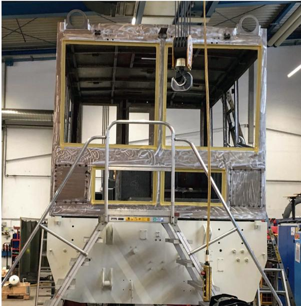
**Abb. 11:** Die komplette Aufarbeitung bzw. Erneuerung der Kabine ermöglicht den Einbau zusätzlicher Fenster mit modernen Befestigungsmethoden.
